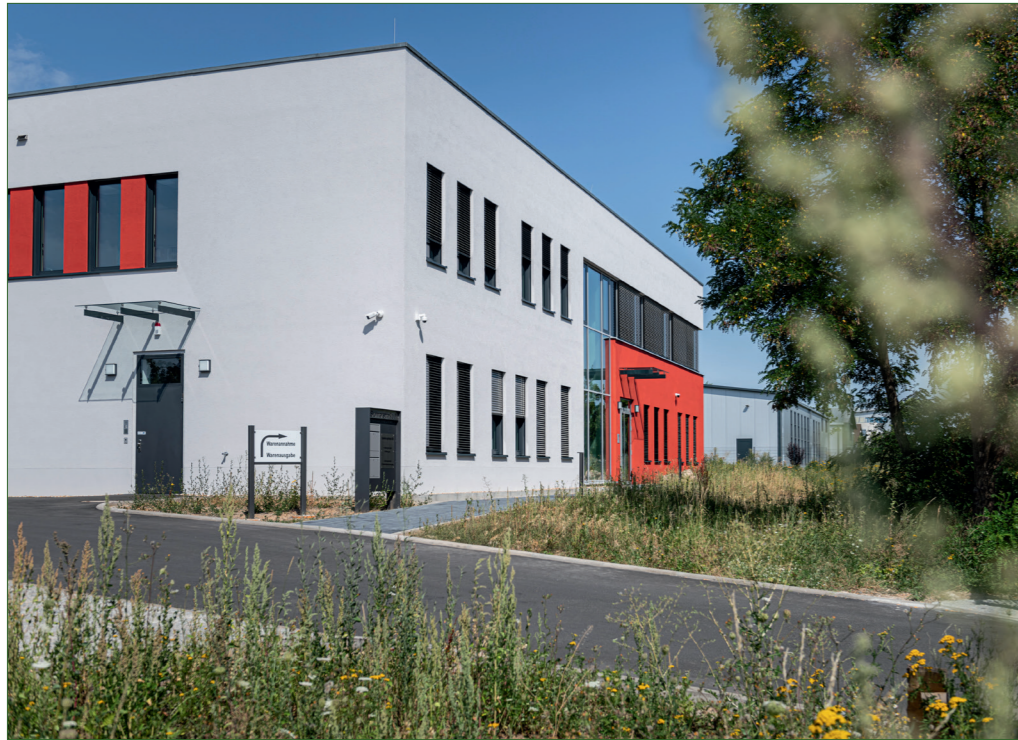
Ansicht des Gebäudes Stöhrerstraße 1 Foto: eric-kemnitz.com
